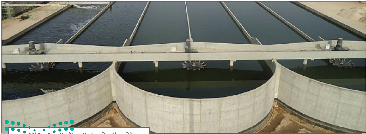
محطة معالجة مياه الصرف الصحي بالرياض
