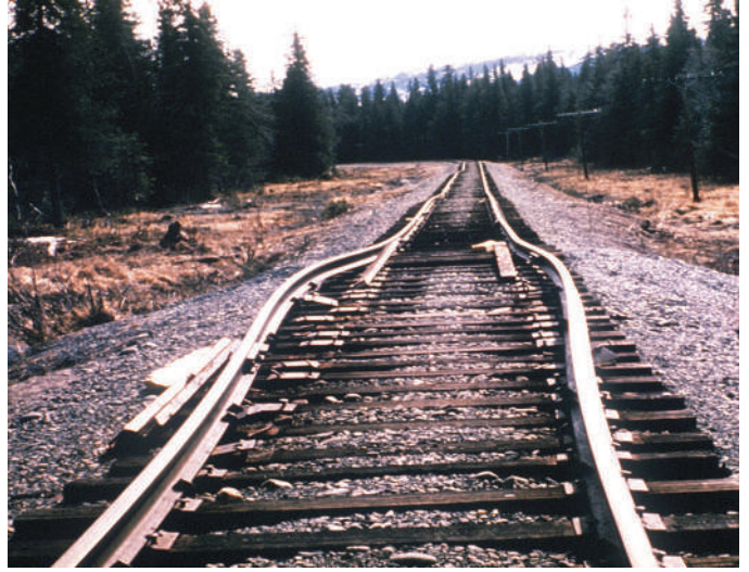
الشكل 20-6 لقد تسببت درجات الحرارة العالية أيام الصيف الحارة في تقوس مسارات سكة الحديد.
