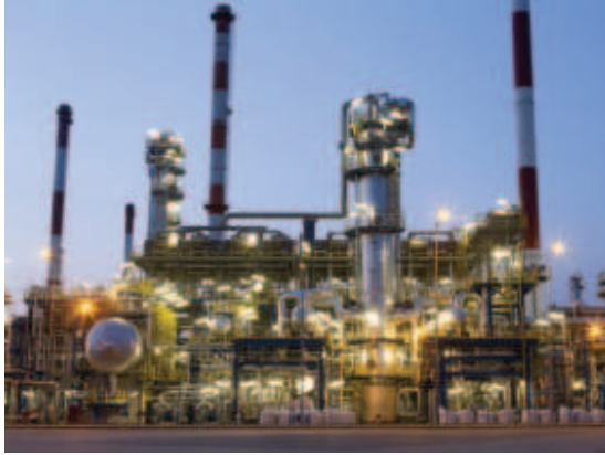
محطة توليد الكهرباء في الجبيل
