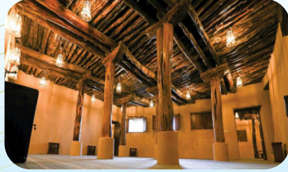
مسجد تاريخي بعد ترميمه
